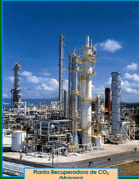
Planta Recuperadora de CO 2 (Malasia)
